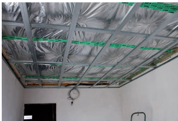
Obr. 2: POLAR+ aplikovaný jako tepelná izolace ve stropě
