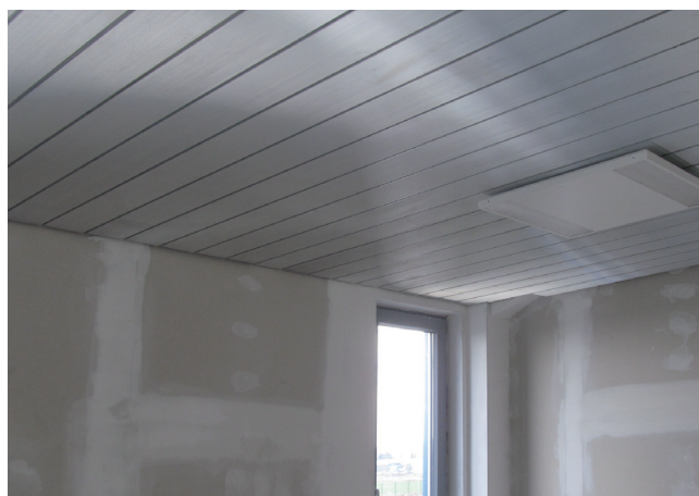
Strop administrativy před vymalováním
